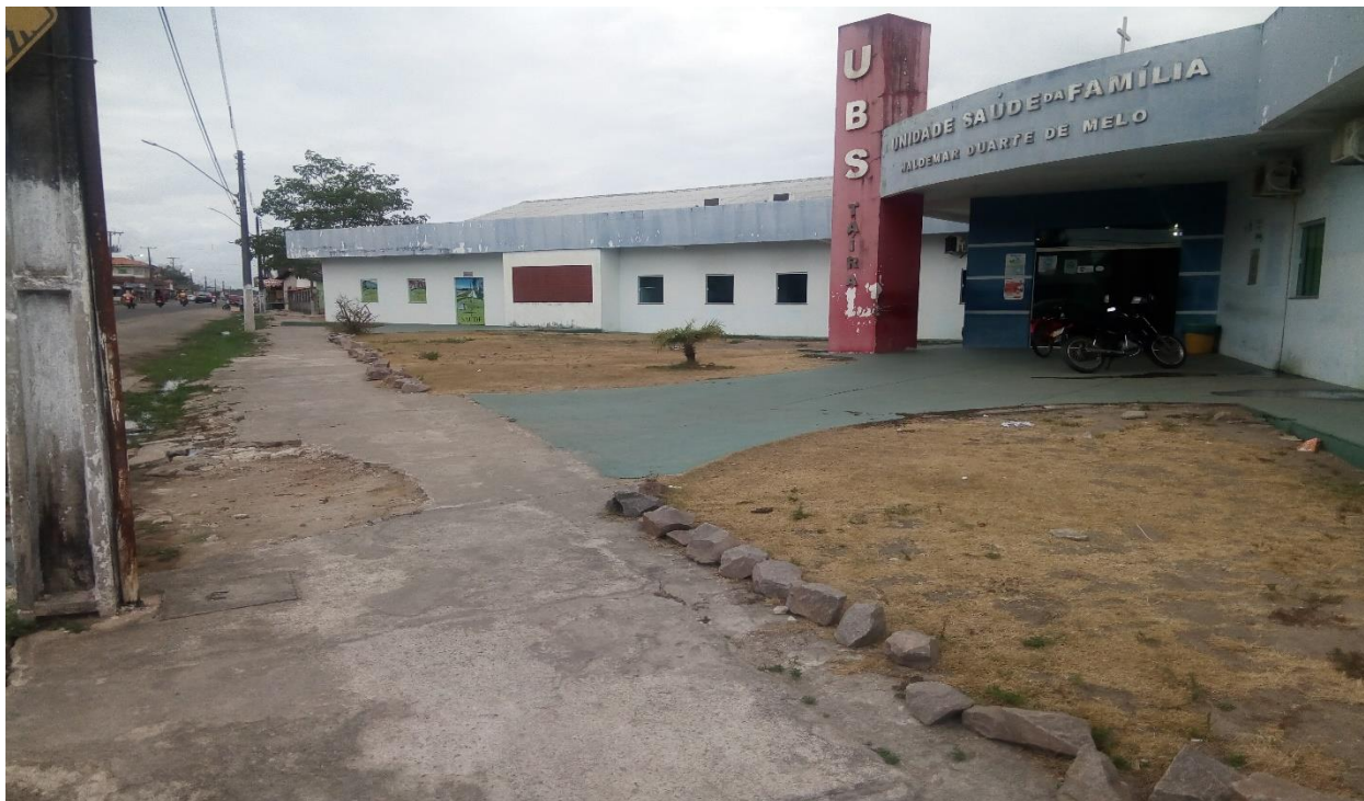
Reg. fotográfico da situação-Engenharia e Fiscalização/SEMUSB/PMB
